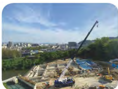
3 建設中の新庁舎 【令和6年5月17日撮影】
