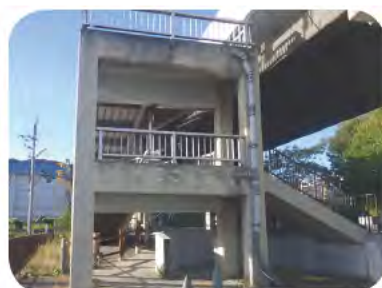
2 橋梁長寿命化補修工事を行う橋梁 (桜井一丁目地内)
