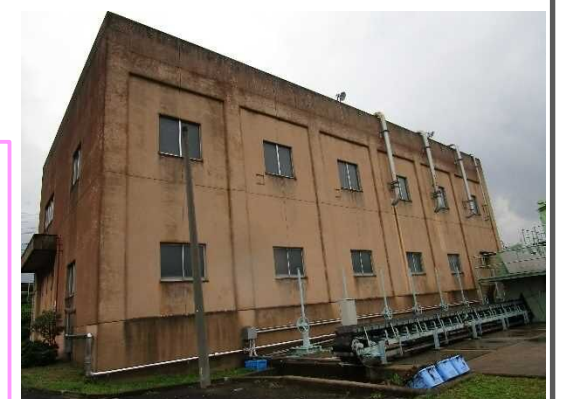
山崎ポンプ場
