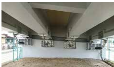
落橋防止装置設置後
