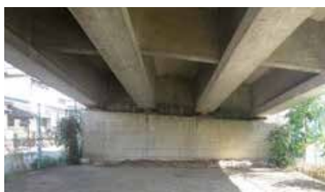
落橋防止装置設置前
