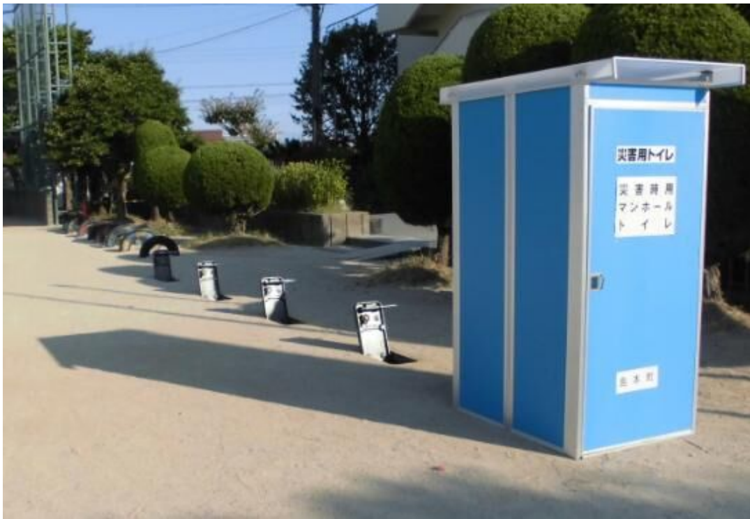
図表 2 - 1 0 災害時に使用するマンホールトイレの実際の設置状況
