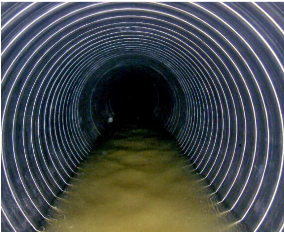
図表 2 - 1 1 管更生後の管渠内部写真
