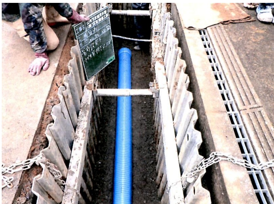
図表 2 - 5 汚水管渠の整備現場写真
