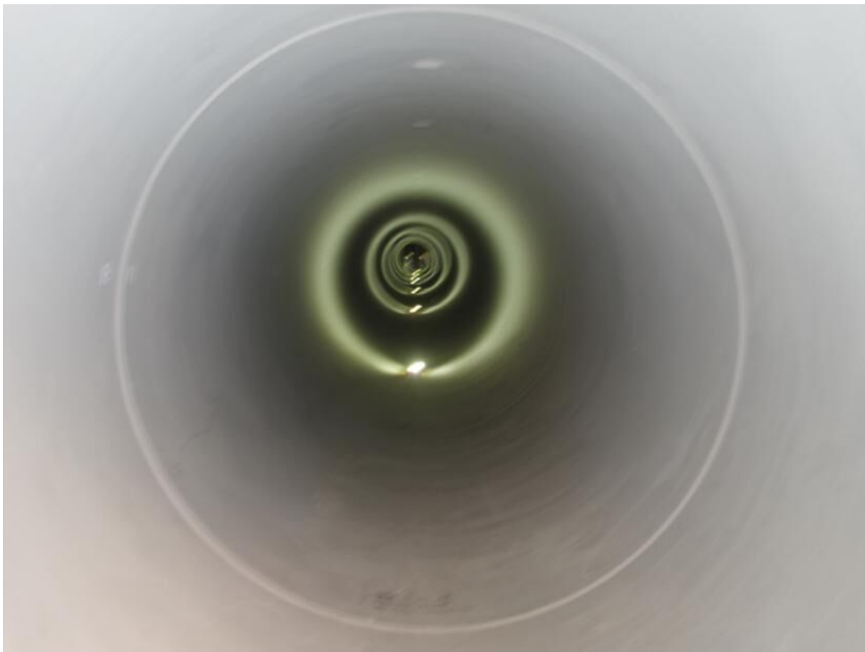
図表 2 - 1 2 雨水幹線の新設管渠内部写真
