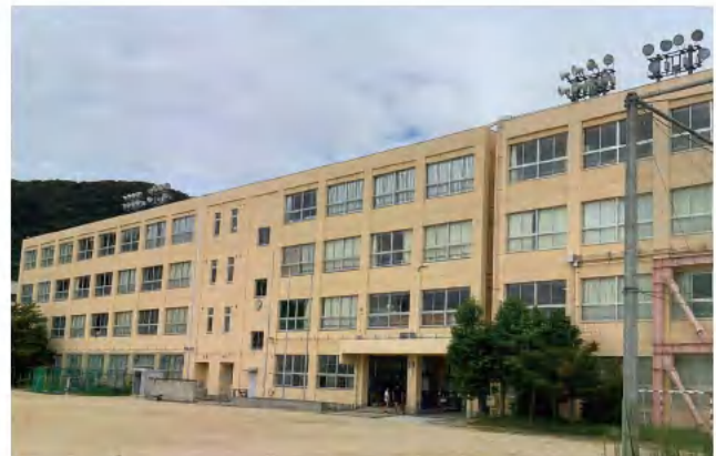
3 空調設備改修工事を行う第二中学校 （8月18日撮影）
