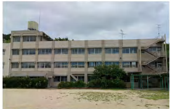
1 長寿命化改修工事を行う第二小学校北館 （8月18日撮影）
