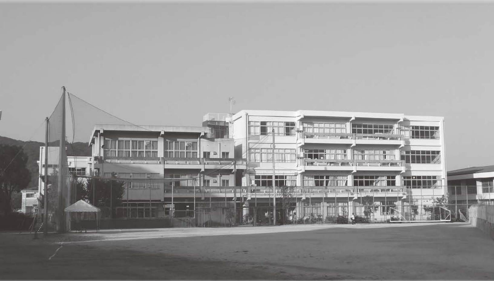
耐震補強工事が完了した第一中学校の校舎 工事も終わり、来月から給食が始まります (平成28年11月7日撮影)
