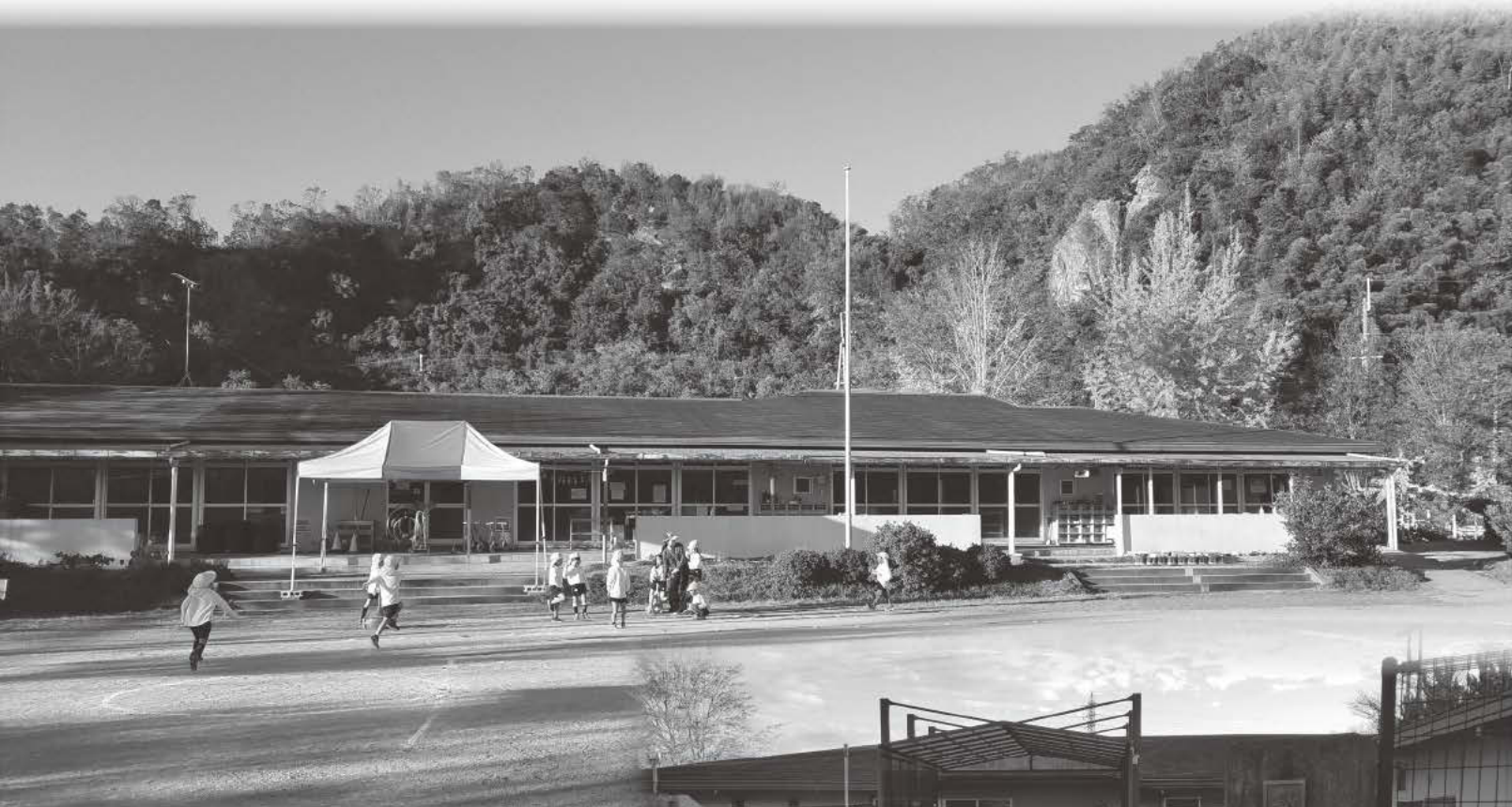
今年度で廃止される町立第二幼稚園 (平成 30 年 11 月撮影)
