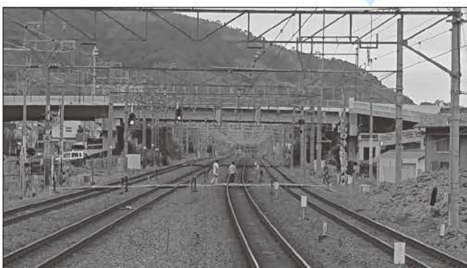
桜井跨線橋補修・補強工事が行われる橋りょう部分
