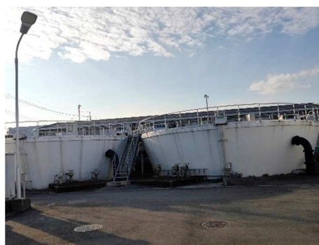
大藪浄水場 高速凝集沈澱池
