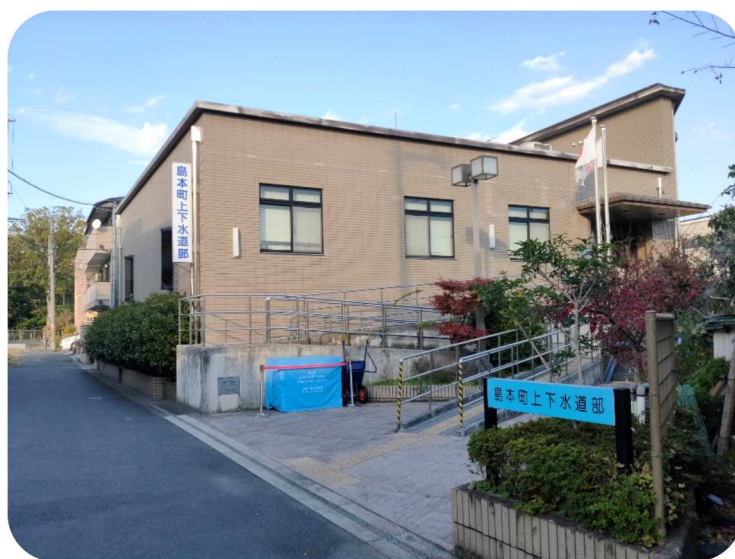
上下水道部庁舎
