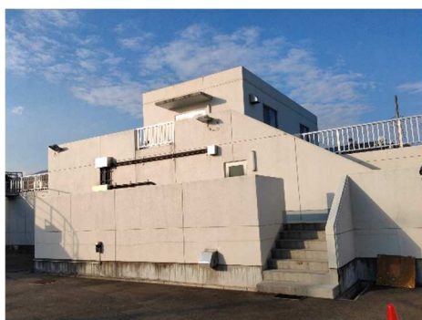
大藪浄水場 急速ろ過池
