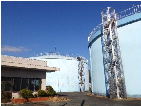
第三,四低区配水池
