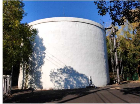
第二高区配水池
