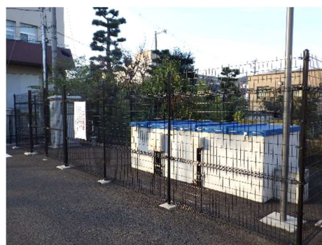
第二大藪取水場
