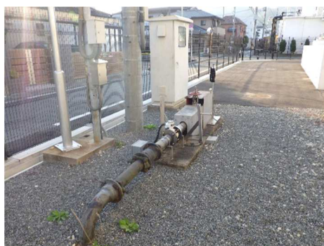
大藪 3 号取水場
