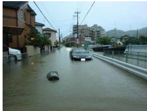
青葉地区の被災状況②
