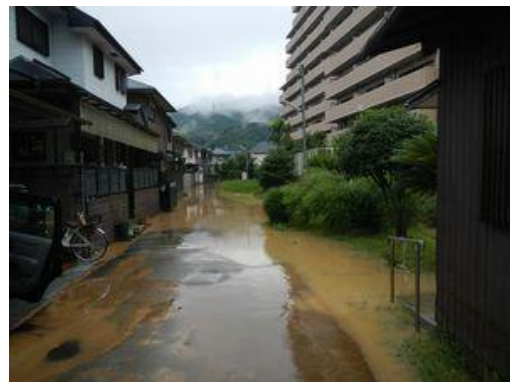
水無瀬地区の被災状況
