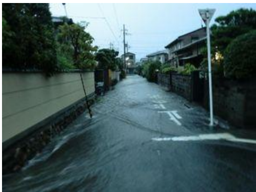
広瀬地区の被災状況
