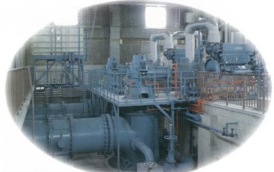
山崎ポンプ場のポンプ室 山崎ポンプ場4号配管川岸線側の雨水対策のため、改修されたポンプ室
