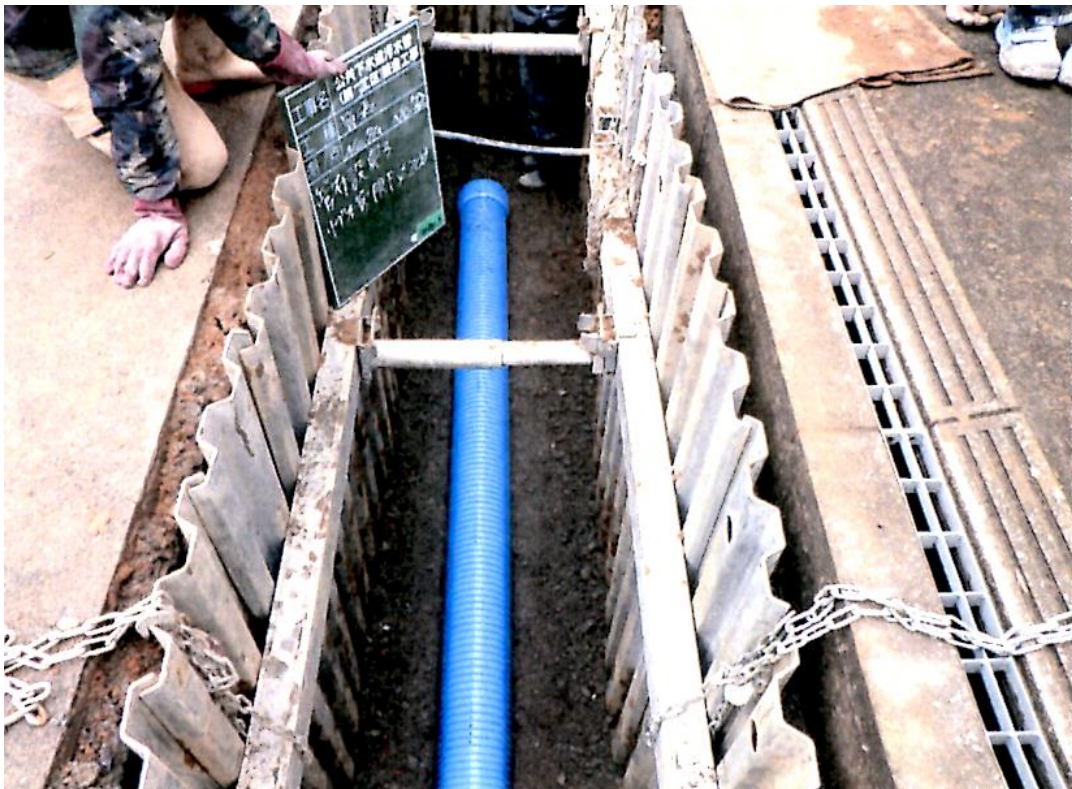
図表 2 - 5 汚水管渠の整備現場写真
