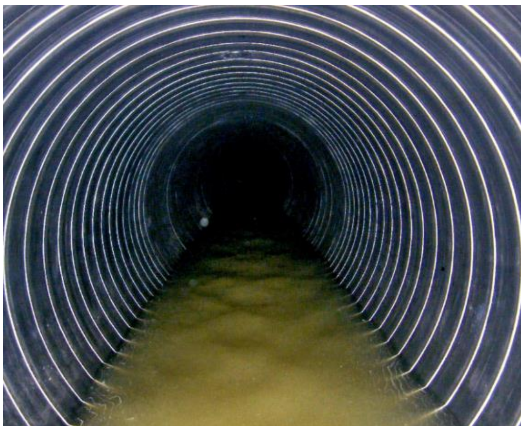
図表 2 - 1 1 管更生後の管渠内部写真
