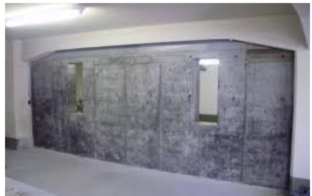
実例写真2: 耐震壁の設置例
