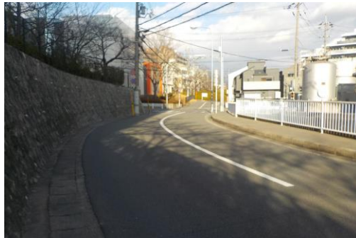
町道広瀬桜井幹線の現状
