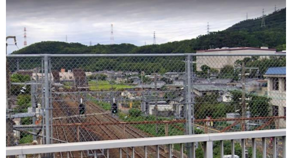
島本町役場付付近高架橋
