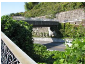
東大寺跨道橋
