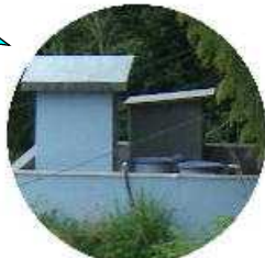
第一高区配水池
