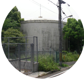
第二高区配水池
