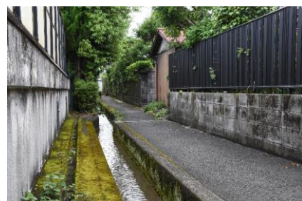
市街地内の水路
