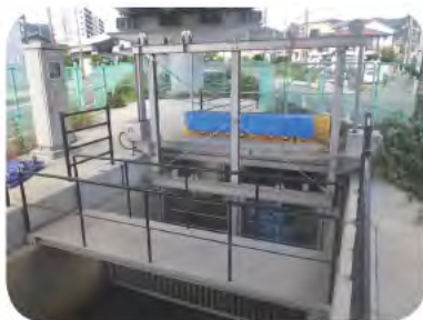
6 監視カメラを設置する予定 の高川水路スクリーン
