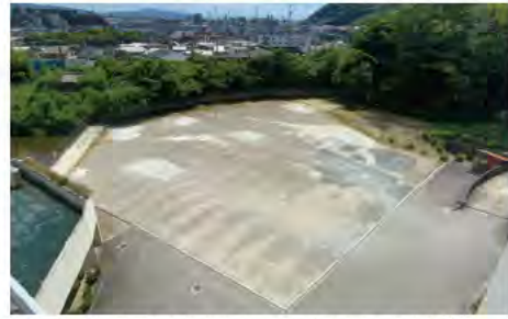
新庁舎が建設される役場中庭 (令和5年8月撮影)
