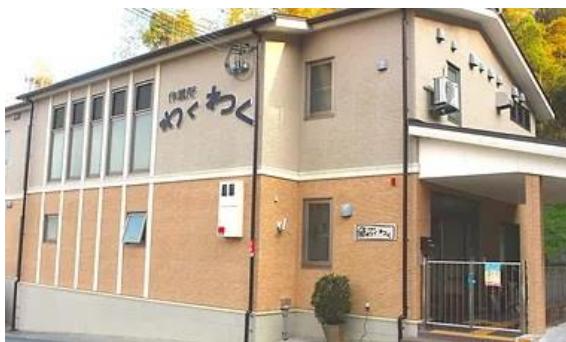
【作業所わくわく外観(若山台)】
