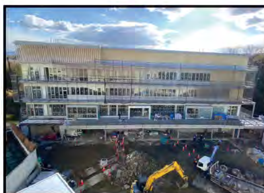
建設中の新庁舎 （令和7年1月7日撮影）
