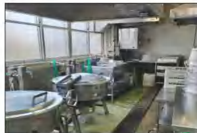
3 第一幼稚園に給食提供が可能となるよう改修を行う第二保育所給食室
