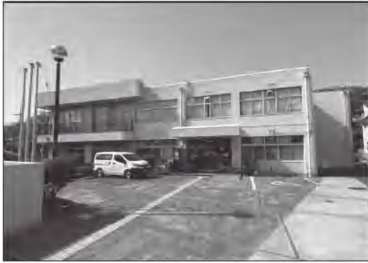
屋上防水及び外壁改修工事とともに、建物内、建物外灯、屋外灯がLED化される町立人権文化センター
