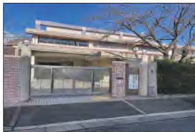
2 令和8年度から給食が提供される第一幼稚園（外観）
