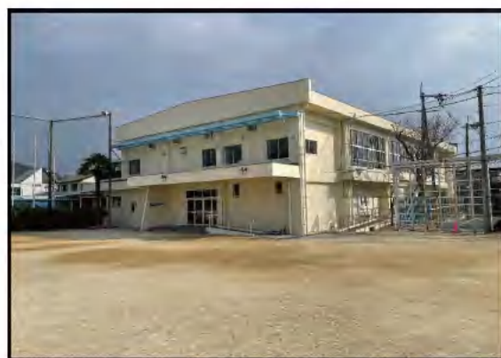
長寿命化改修工事が完了した町立第一小学校体育館
