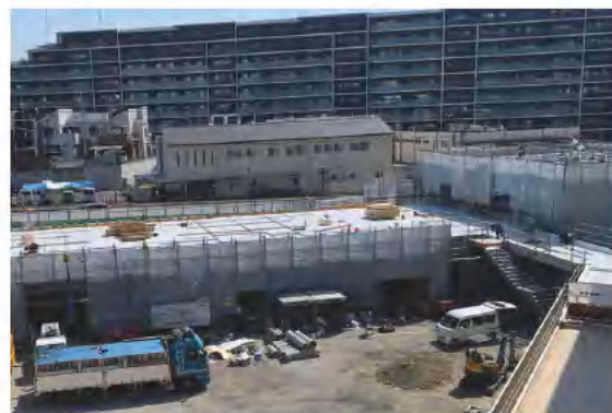
1 広場棟建設のため減築改修工事中の旧庁舎【令和8年5月15日撮影】 （令和8年7月完成予定）
